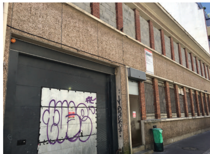
Destruction du 36 rue Roquelaine. Il paraît que c'est moins cher que de réaménager. Quid de l'empreinte carbone ?
