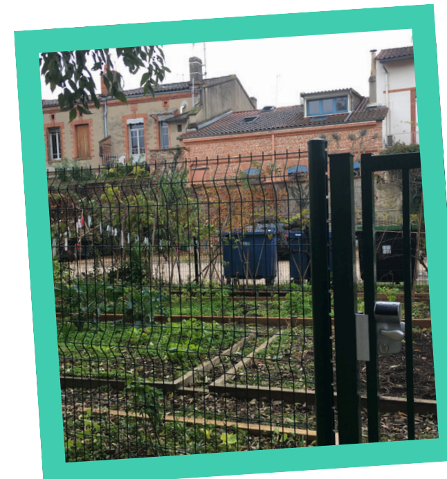
Réparation des dégradations au jardin du Verrier, changement de la clôture et du portail pour éviter le vandalisme
