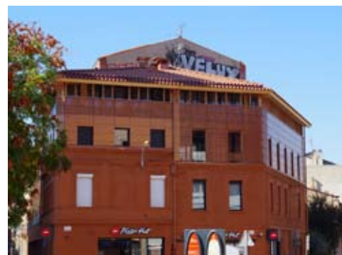
Une importante et récente surélévation
